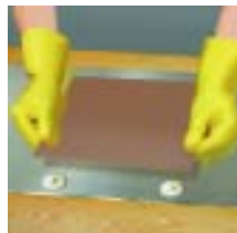
Līmes uzklāšana elastīgai līmēšanai punktveida vai stīgas formā. Atkarībā no virsmas gluduma pakāpes līmes šuvi saspiež līdz 1–3 mm biezumam
