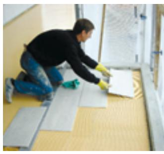
Līmi ar labām sekmēm var izmantot gadījumos, ja vecās flīzes ir nodilušas vai ja zem tām esošā hidroizolācija ekspluatācijas laikā ir zaudējusi ūdensnecaurlaidību. Šajā gadījumā jaunās flīzes var līmēt tieši virsū vecajām. Tā tiek atjaunota gan hidroizolācijas kārta, gan arī nostiprinātas jaunās flīzes. Šādi iespējams samazināt remonta laiku un izvairīties no izmaksām, kas būtu nepieciešamas veco flīžu noņemšanai un zem tām esošās pamatnes izlīdzināšanai.
