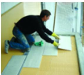
Līmi ar labām sekmēm var izmantot gadījumos, ja vecās flīzes ir nodilušas vai ja zem tām esošā hidroizolācija ekspluatācijas laikā ir zaudējusi ūdensnecaurlaidību. Šajā gadījumā jaunās flīzes var līmēt tieši virsū vecajām. Tā tiek atjaunota gan hidroizolācijas kārtā, gan arī nostiprinātas jaunās flīzes. Šādi iespējams samazināt remonta laiku un izvairīties no izmaksām, kas būtu nepieciešamas veco flīžu noņemšanai un zem tām esošās pamatnes izlīdzināšanai.
