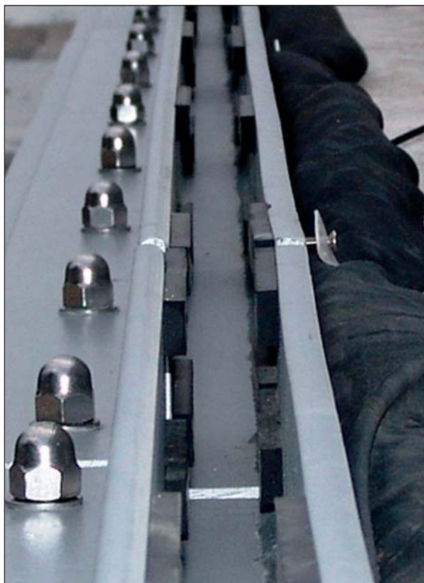
5. attēls. Stikla fiksēšanas bloki U veida kanālā
